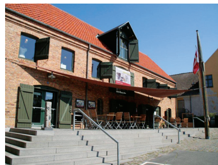
Grønbechs Gård i Hasle Grønbechs Gård, Hasle
